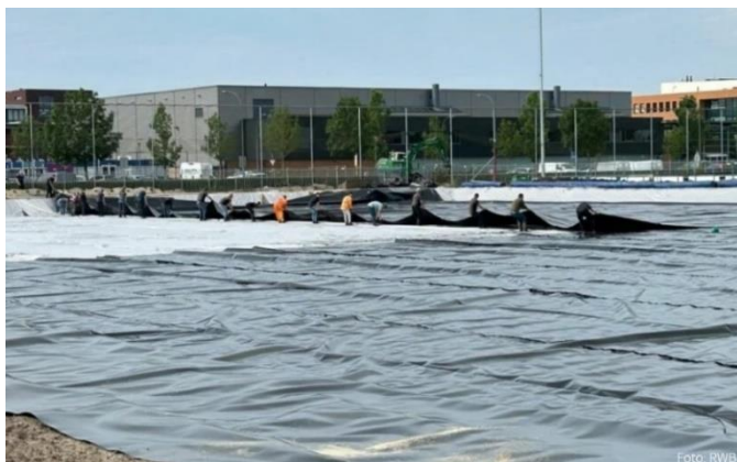
Waterdicht maken van de bassins
